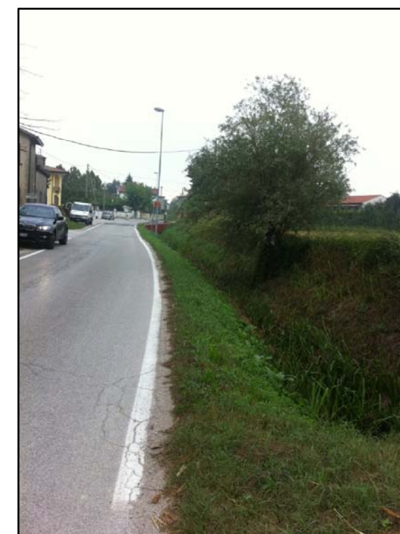
5: Fosso su Via Callesette verso Via Castellaro Alto
