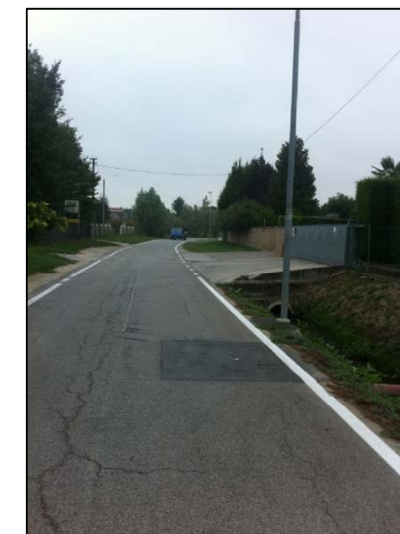
6: Fosso su Via Callesette verso Via Castellaro Alto
