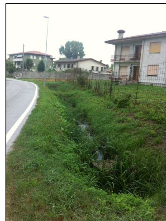
4: Fosso su Via Callesette verso Via Castellaro Alto
