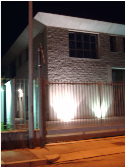
Insedimento industriale con illuminazione non conforme.
