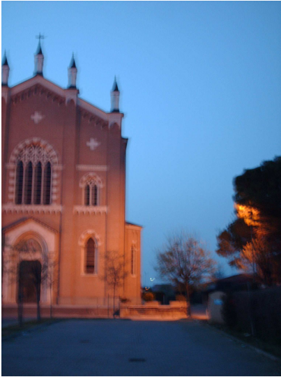
Facciata del Duomo
