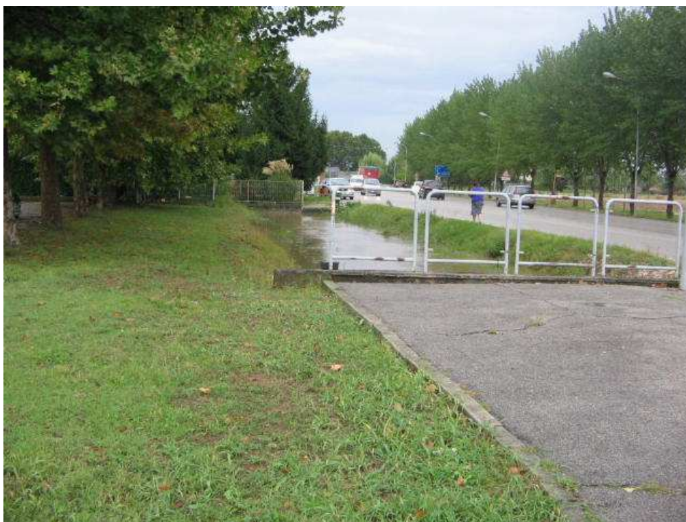
scolo consortile a ingresso viale Industria
